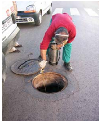
Foto 3: Fumigado de alcantarilla contra cucarachas
